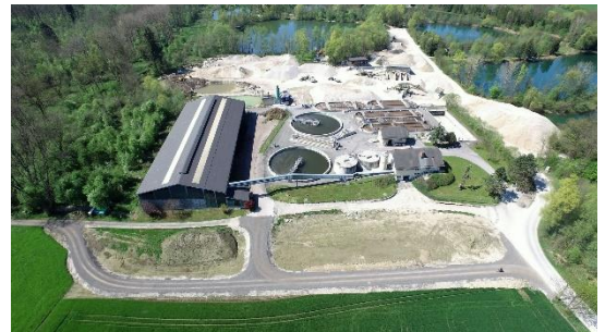
WWTP PLADENBACH (A)
